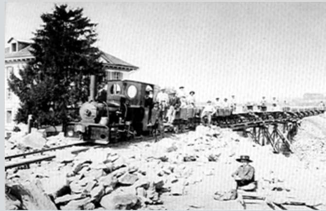
Bahnbau bei Männedorf
